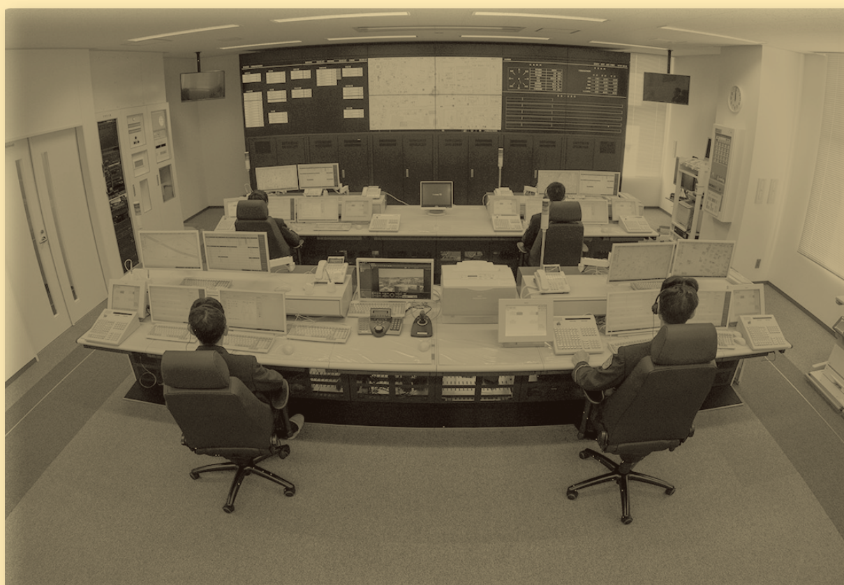
高機能消防指令センター
